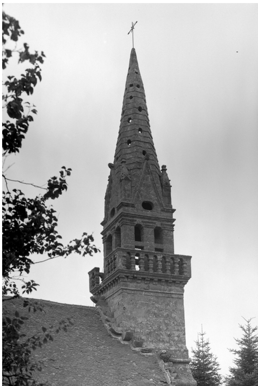
Clocher, face nord : vue générale
