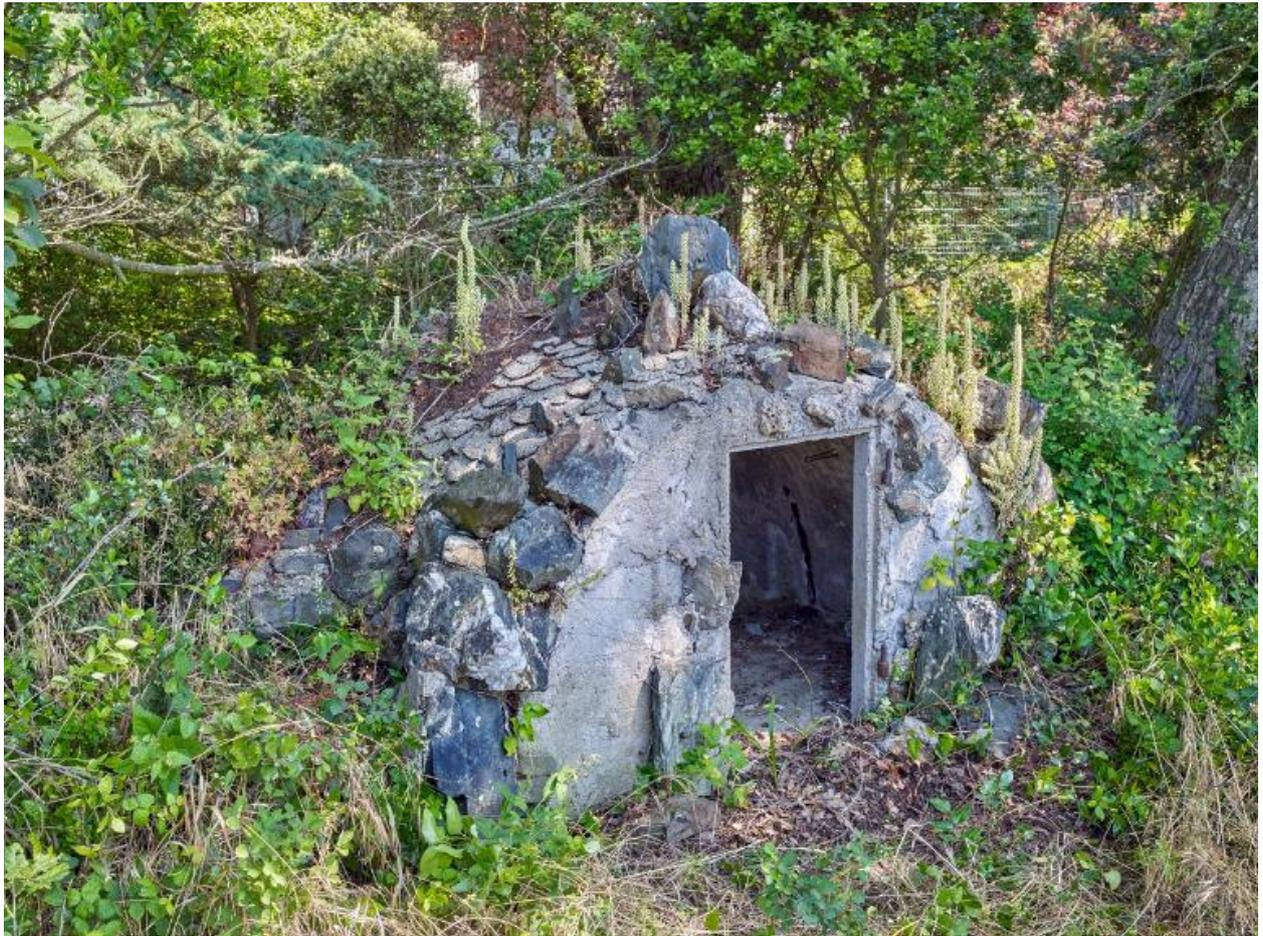
Vue de la grotte artificielle (faisant abri pour un ou des animaux) du bassin : élévation Sud percée d'un porte. Sa couverture est ornée de coquilles Saint-Jacques en ciment et de rocaille
