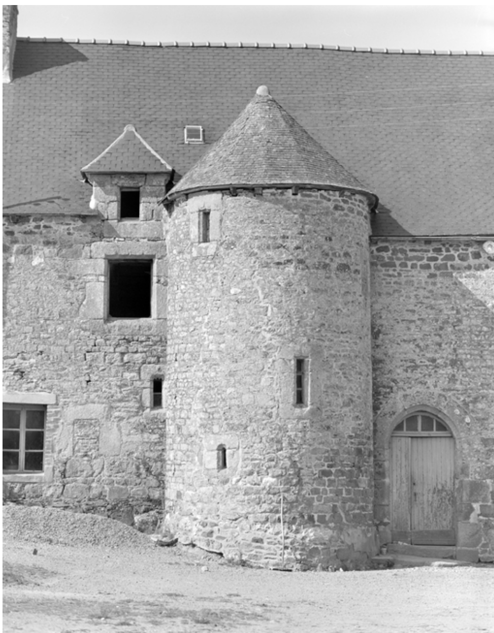
Vue de la tour, face ouest
