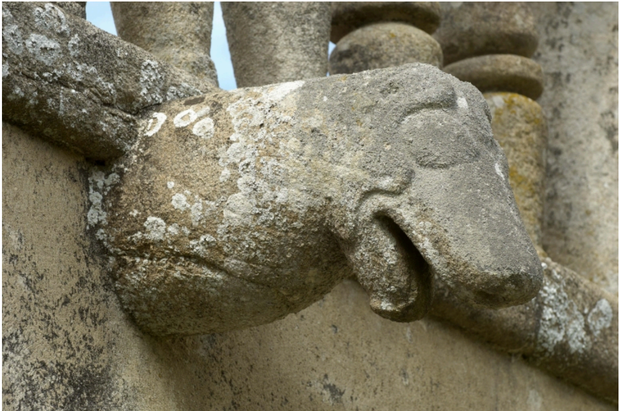
Corps de passage, détail gargouille
