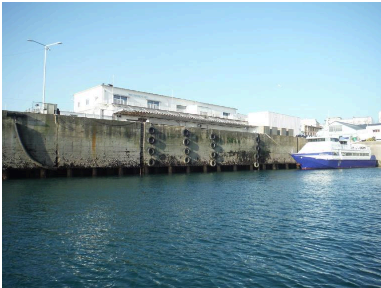
1er éperon, quai est, vue depuis le 2e bassin
