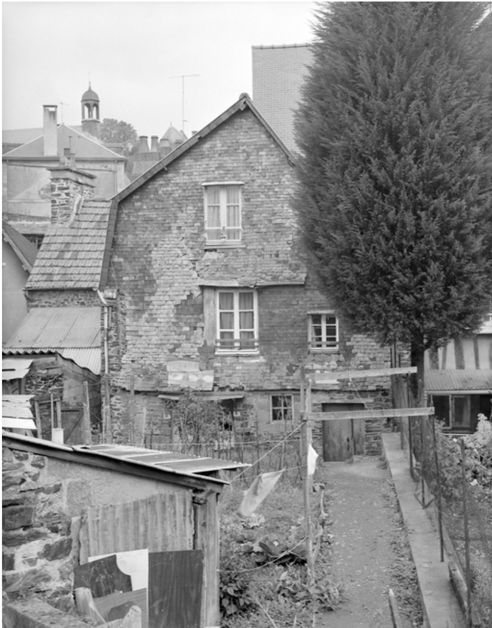
Vue générale de l'élévation postérieure.
