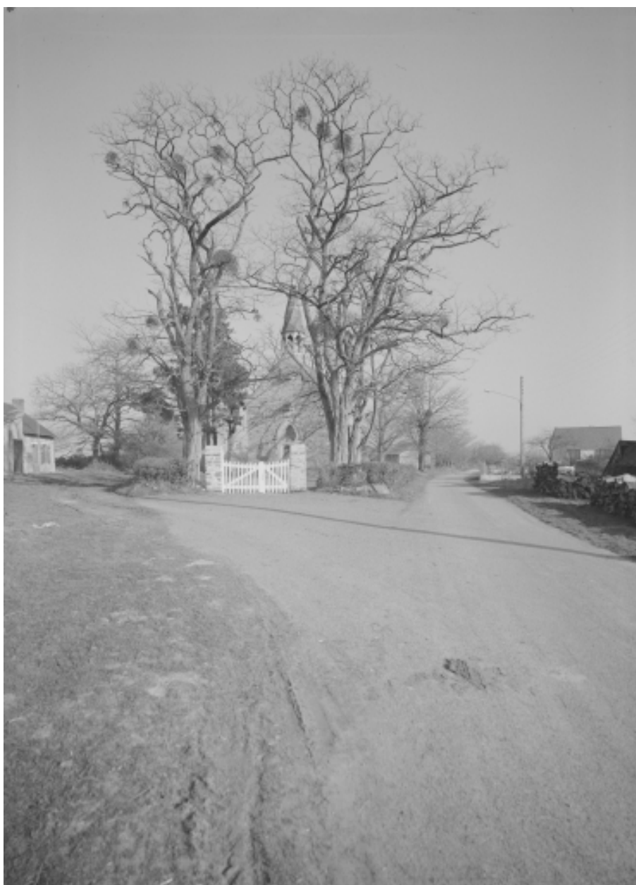
Elévation Ouest : vue de situation
