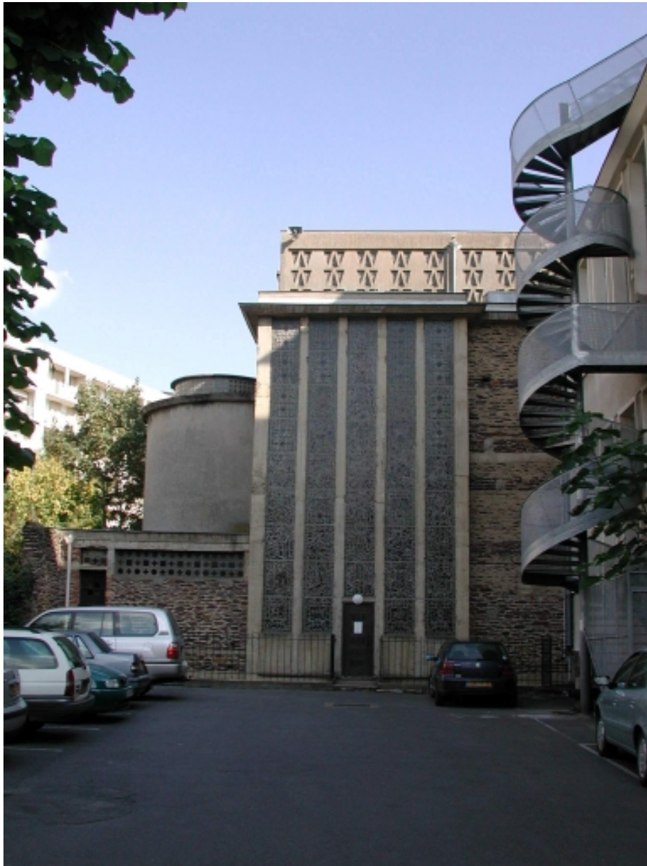
Vue du mur ouest du chœur
