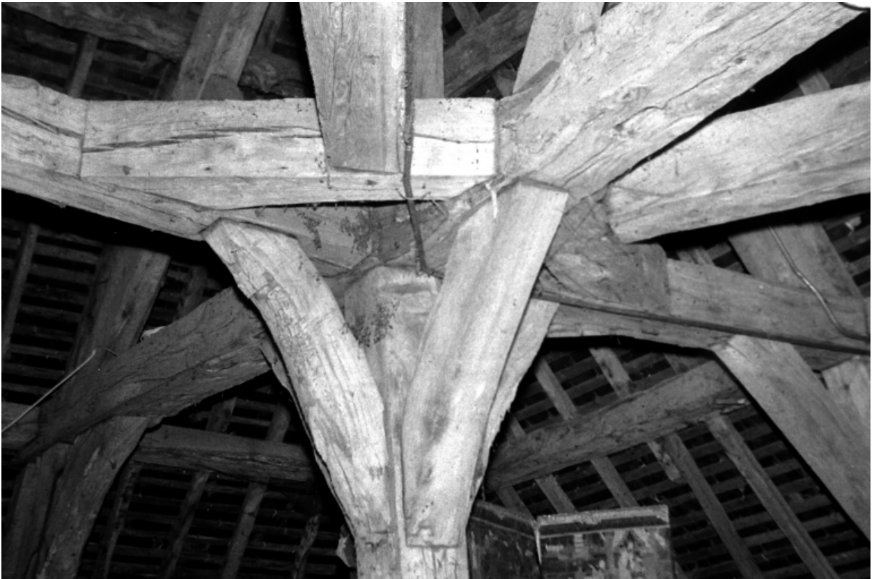
Charpente, vue générale.
