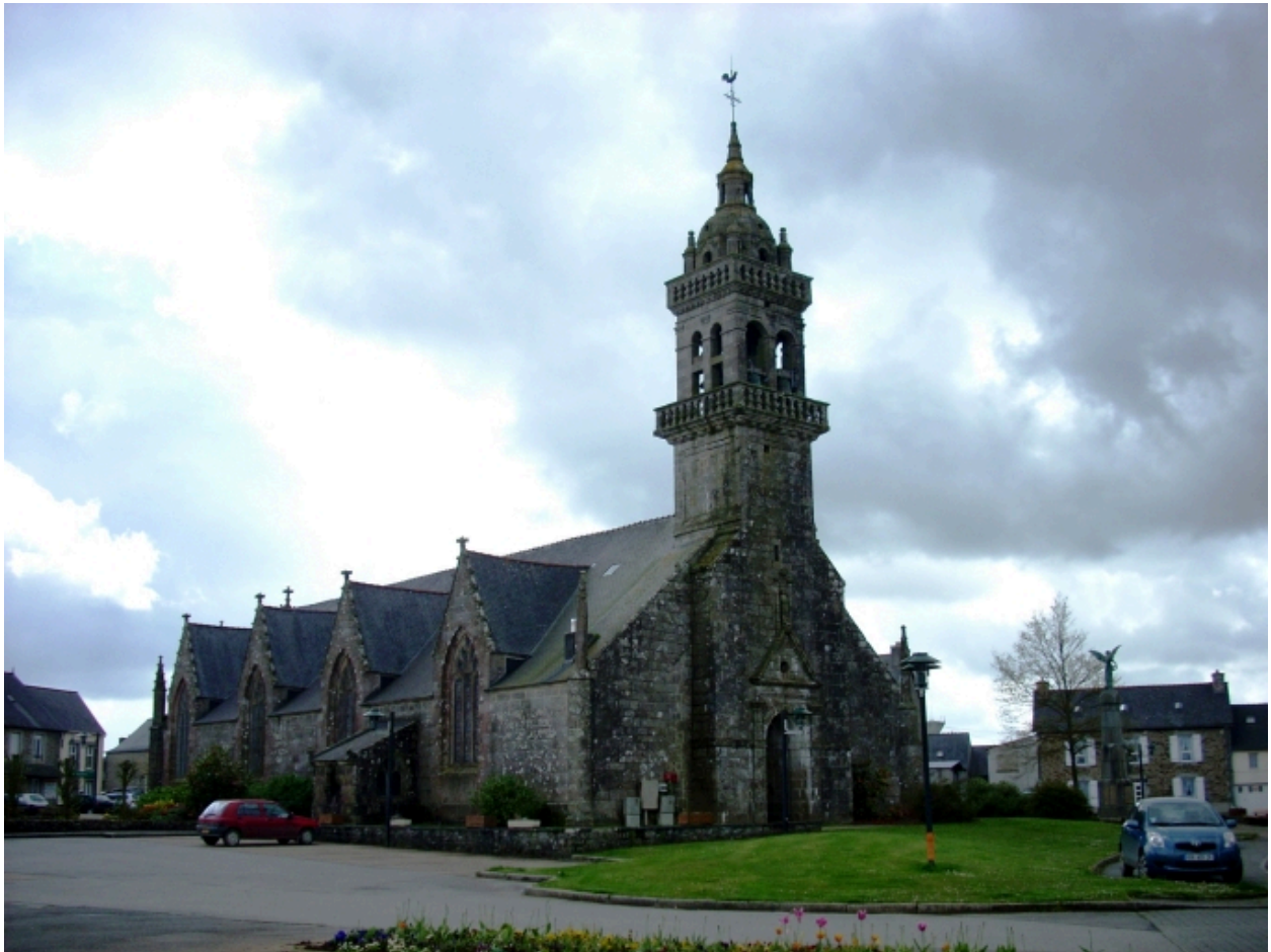
Plonévez-du-Faou, église paroissiale Saint-Pierre : vue générale nord-ouest
