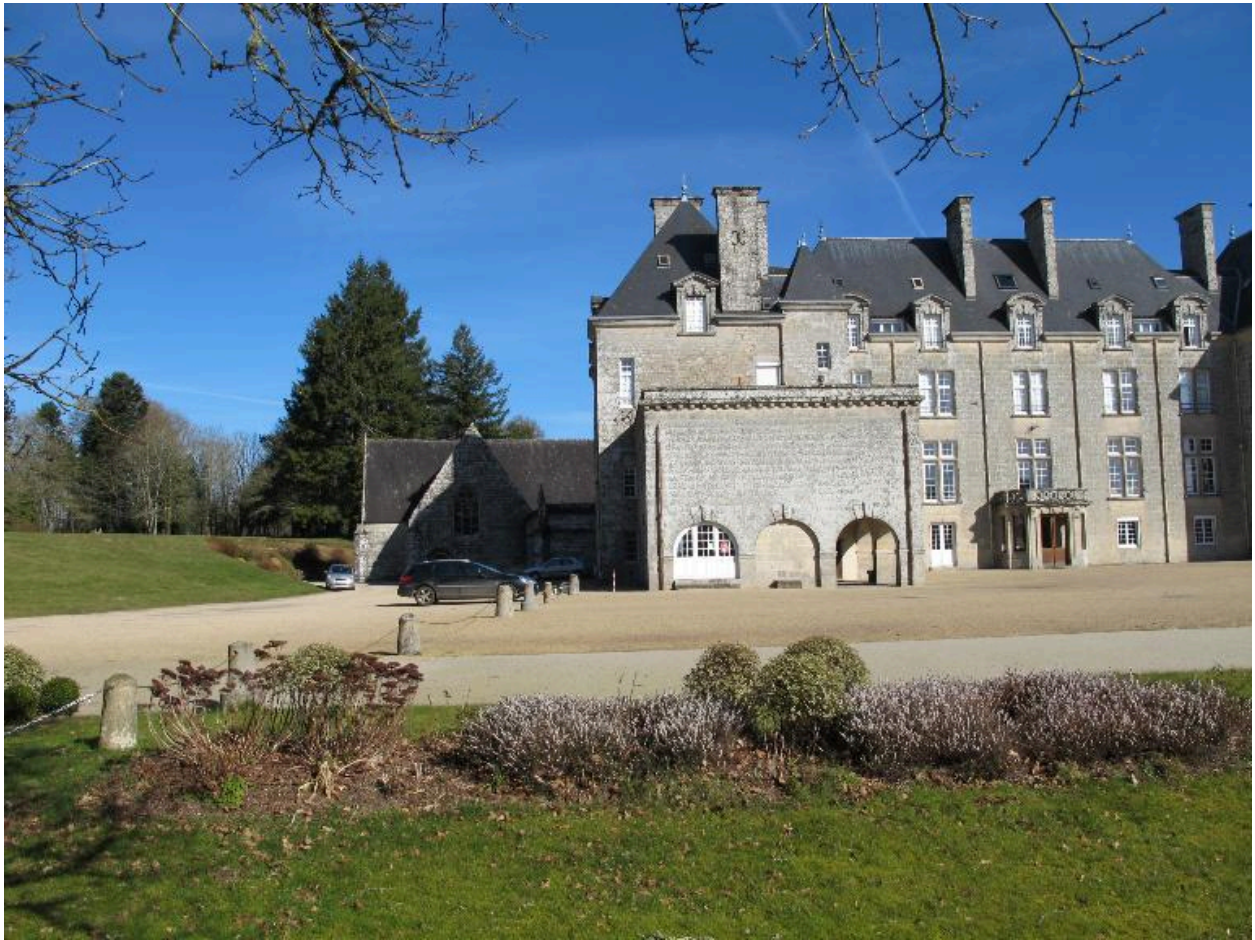
Vue sud du logis et de la chapelle sainte Anne provenant de Pluméliau, état en 2015
