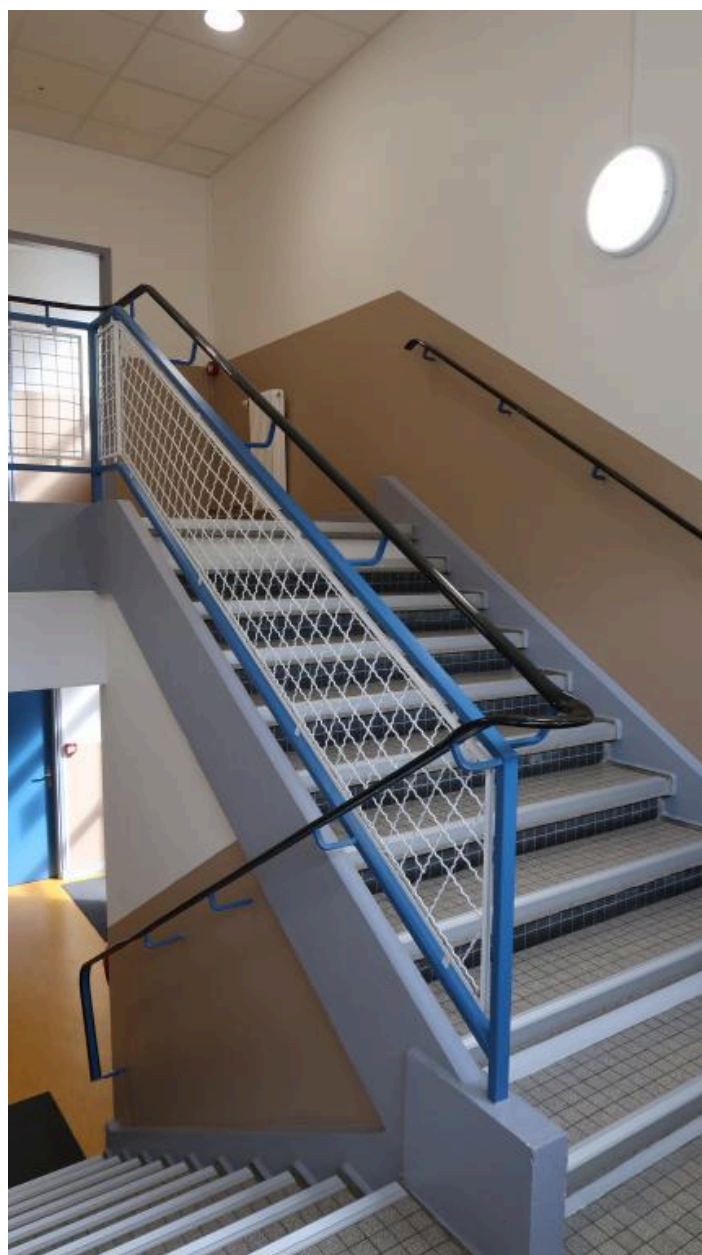
Cage d'escalier dans l'externat. Yves Guillou, architecte, 1969.
