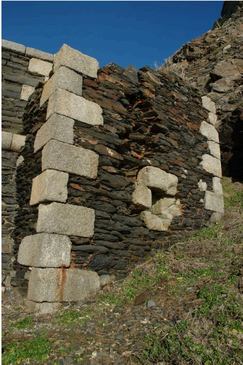
Vue de la batterie de Cornouaille : latrines. Chaînes et encadrement de l'exutoire en granite, remplissage en moellons de schiste
