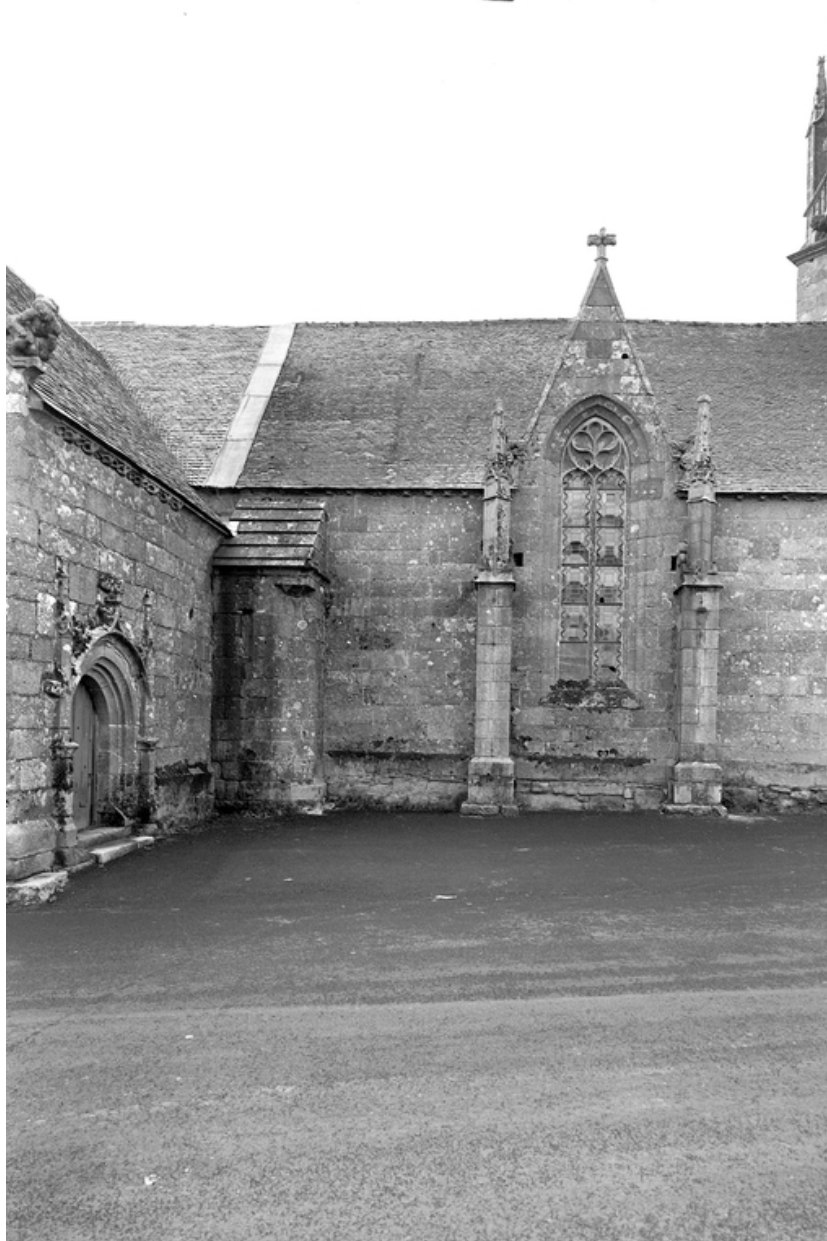
Façade nord : mur nord de la nef, et mur ouest du croisillon occidental
