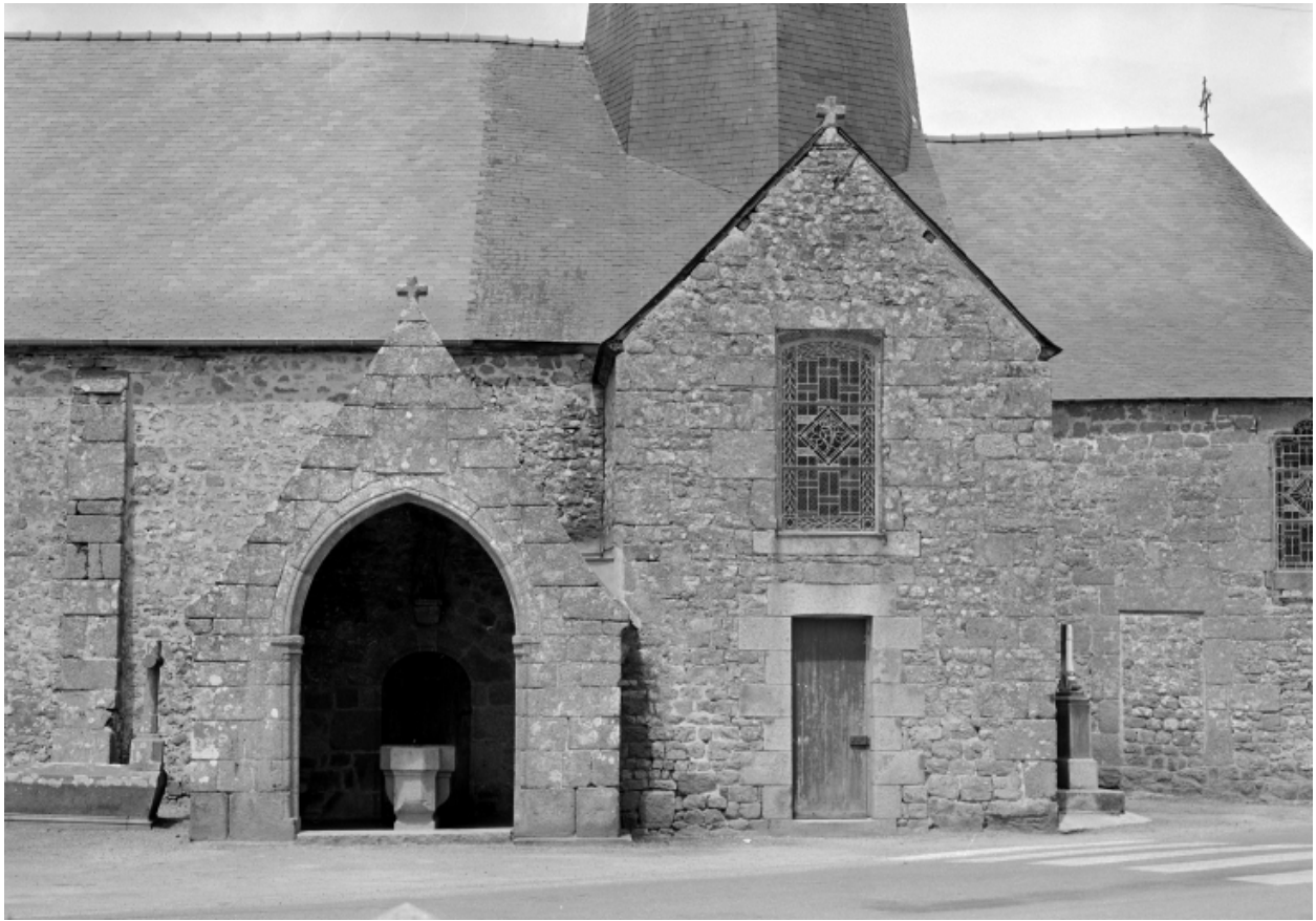
Elévation sud, partie centrale, porte sud : vue générale
