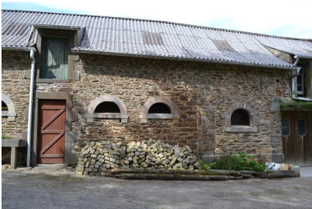
Blanchisserie du Leck. Façade sud. Détail
