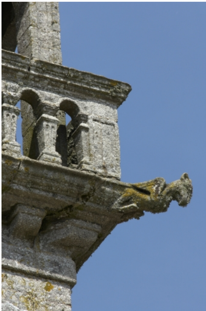
Tour-porche, détail d'une fausse gargouille
