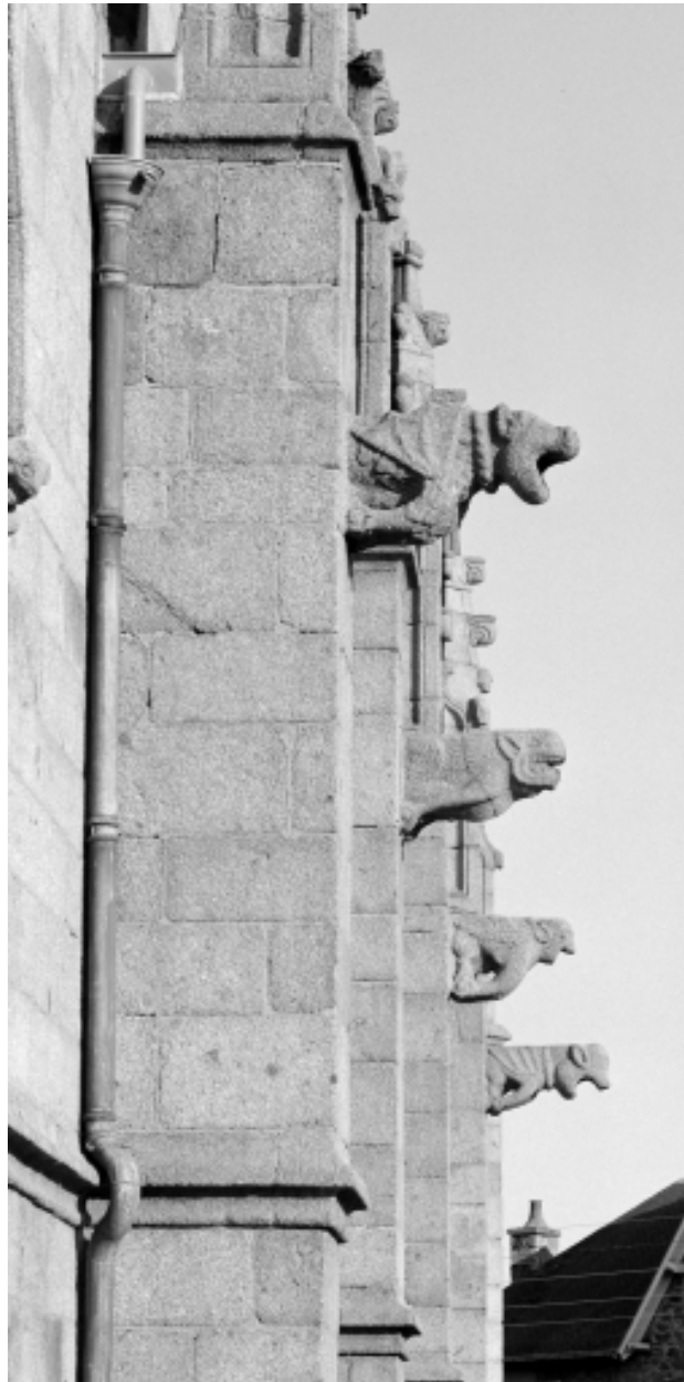
Enfilade de gargouille : vue générale
