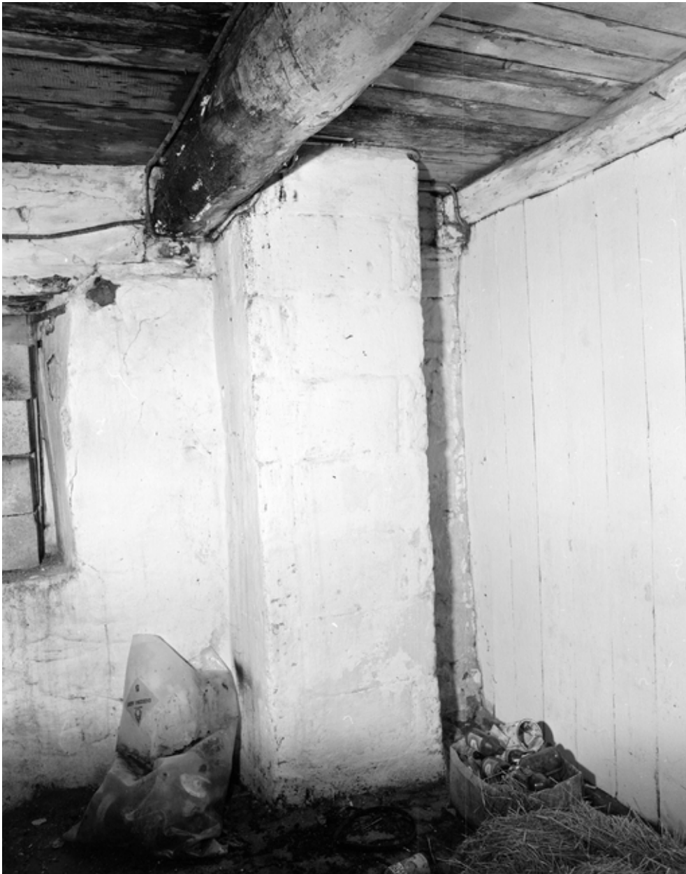
Pièce est, puits, vue intérieure. (1979)
