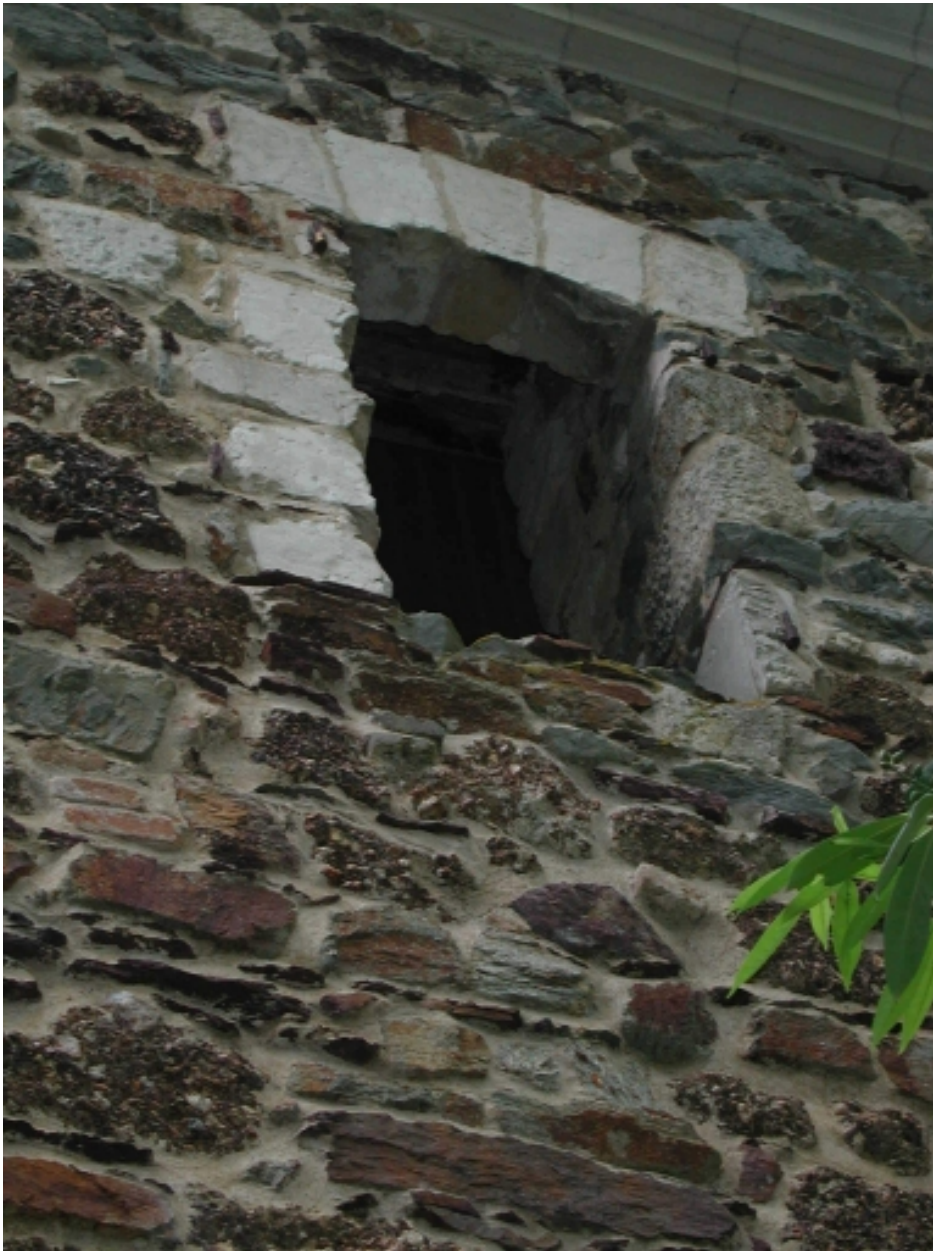
Détail sur l'accès à la chambre des cloches
