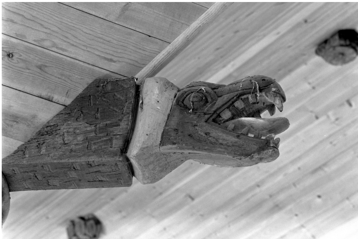
Croisée du transept, angle sud ouest : blochet d'angle
