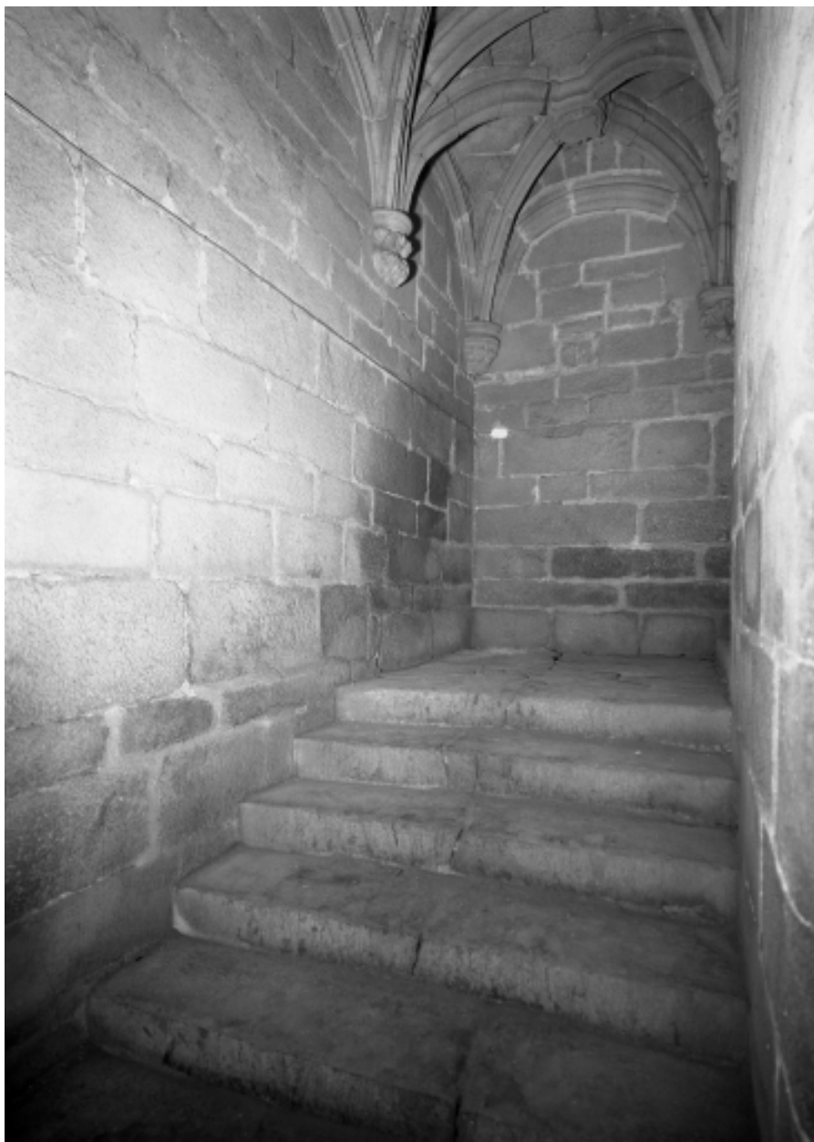
Escalier, 1ère volée du rez-de-chaussée : vue générale (axe est ouest)
