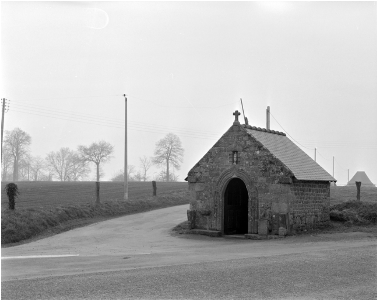
Élévation Nord-Est : vue générale
