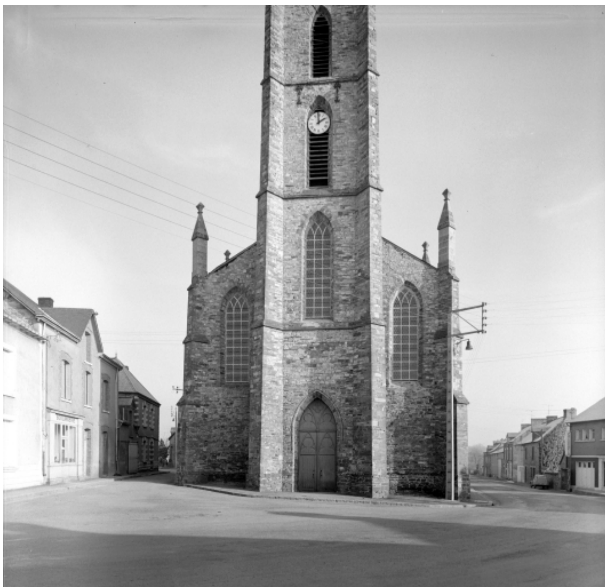
Elévation Ouest : vue générale
