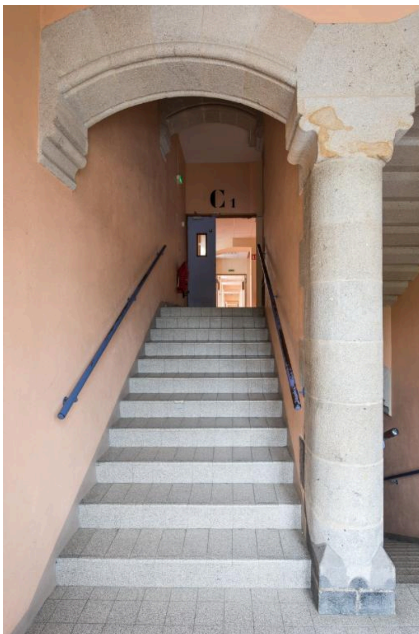
Cage d'escalier dans l'ancien séminaire.
