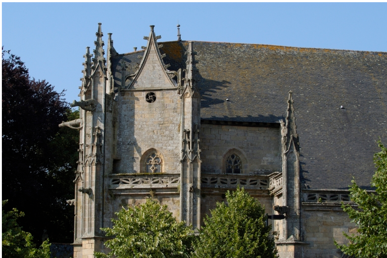
Vue large chevet côté sud parties hautes
