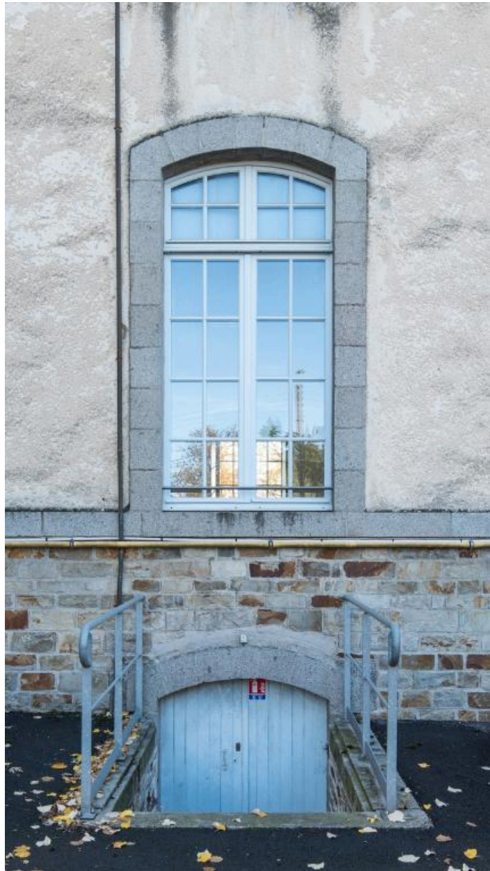
Bâtiment A, logements, détail sur une travée de la façade nord : fenêtre du rez-de-chaussée et porte de cave.
