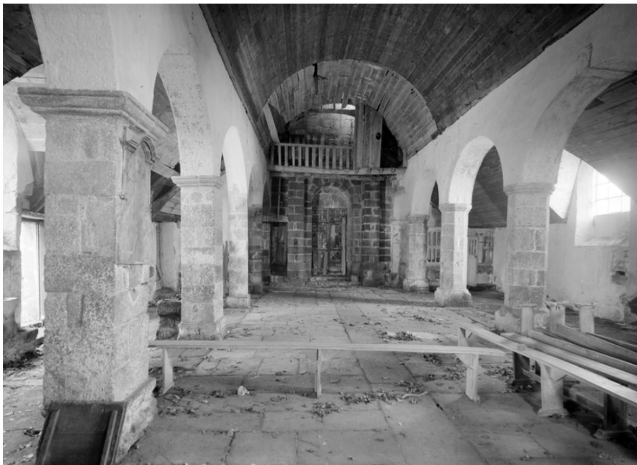
Vue générale d'est en ouest
