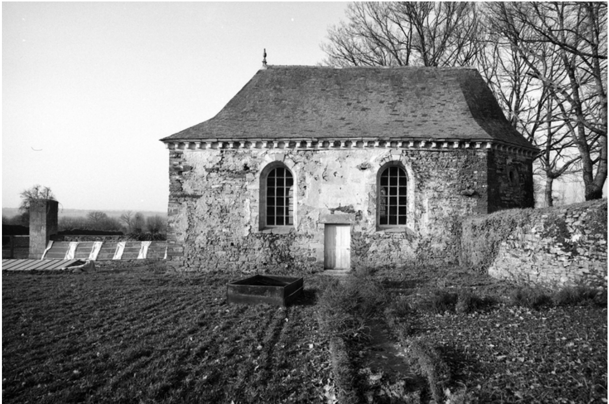
Chapelle, face sud, vue générale.
