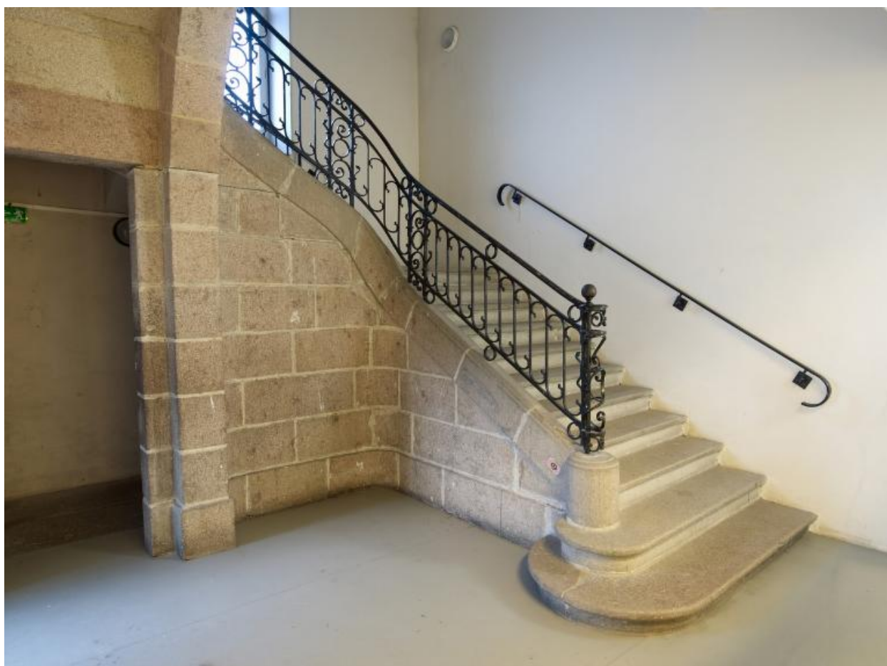
Tréguier : petit séminaire actuellement lycée Joseph Savina, escalier en granite avec garde-corps en fer forgé
