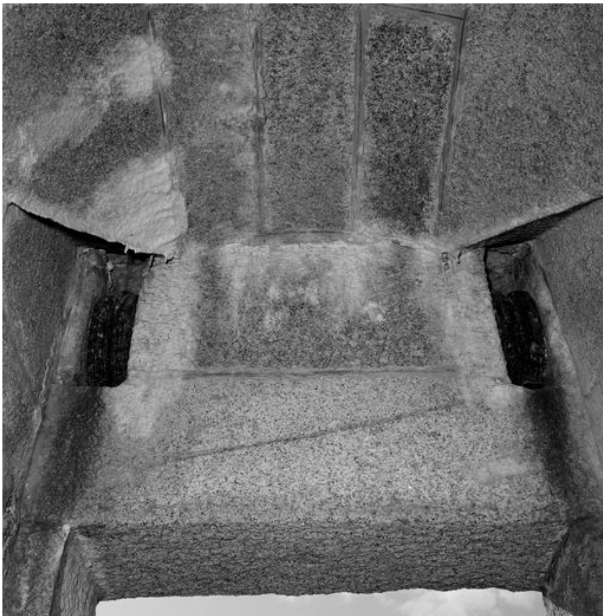
Camaret-sur-Mer, pointe du Toulinguet : vue de la tour-modèle n° 3 en 1969, entrée, passages des chaînes de manoeuvre du pont-levis
