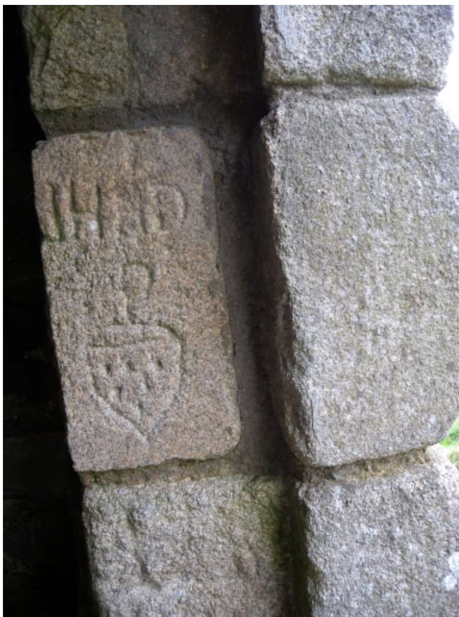
Vue de la pierre maçonnée et sculptée servant de contrefort intérieur au niveau de l'ouverture principale (à droite)
