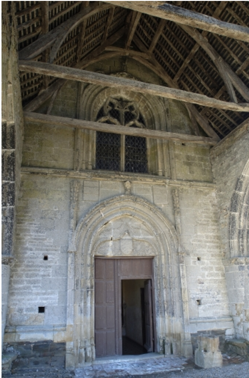
Façade ouest prise de l'intérieur du porche
