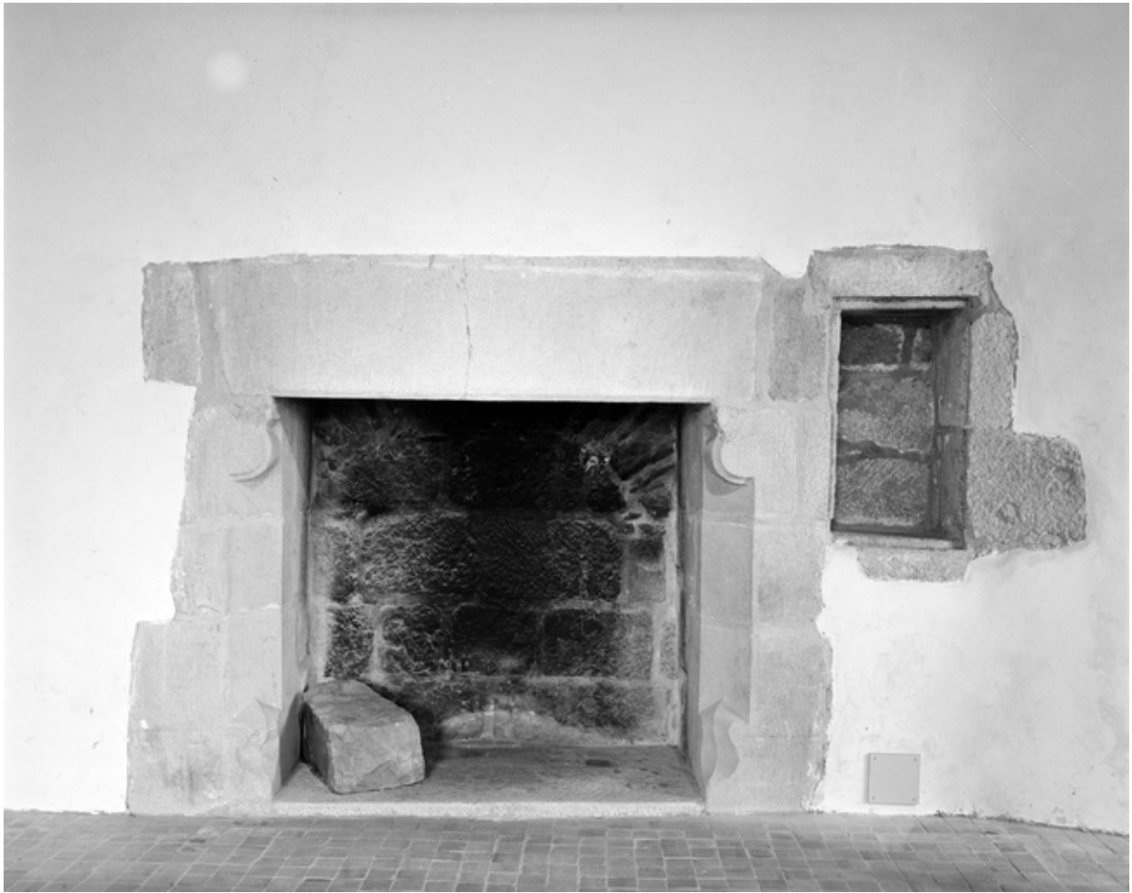
Vue de la chambre sud-est du deuxième étage : cheminée et niche murale (état en 1989)
