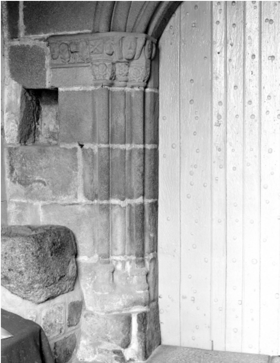
Entrée sud : détail de l'ébrasement
