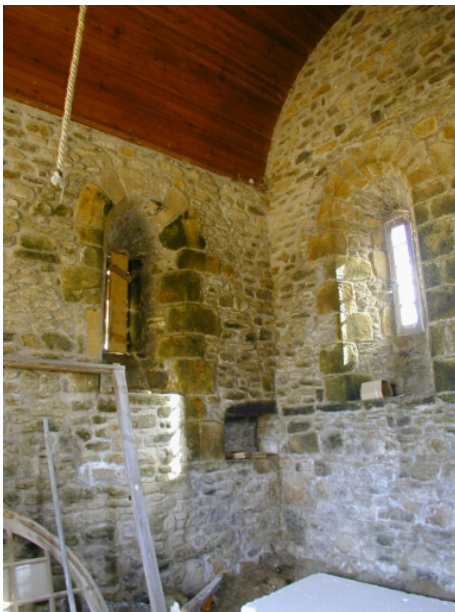
Vue intérieure du chevet et du mur latéral Nord en cours de restauration, 2004 (SRA)
