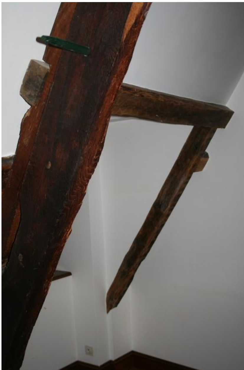
Chevron de la charpente
