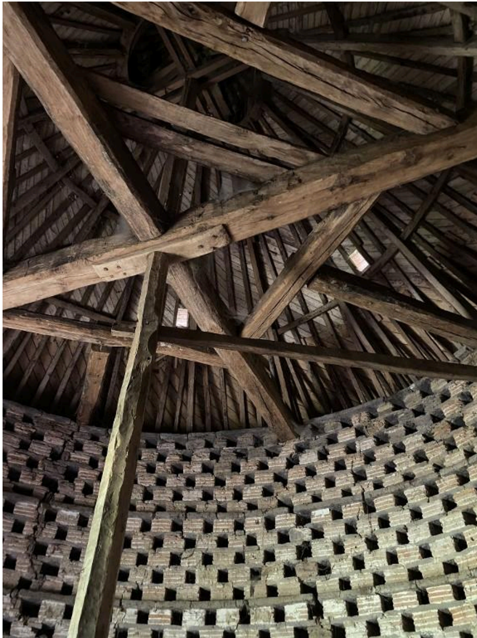
Charpente du colombier, détail
