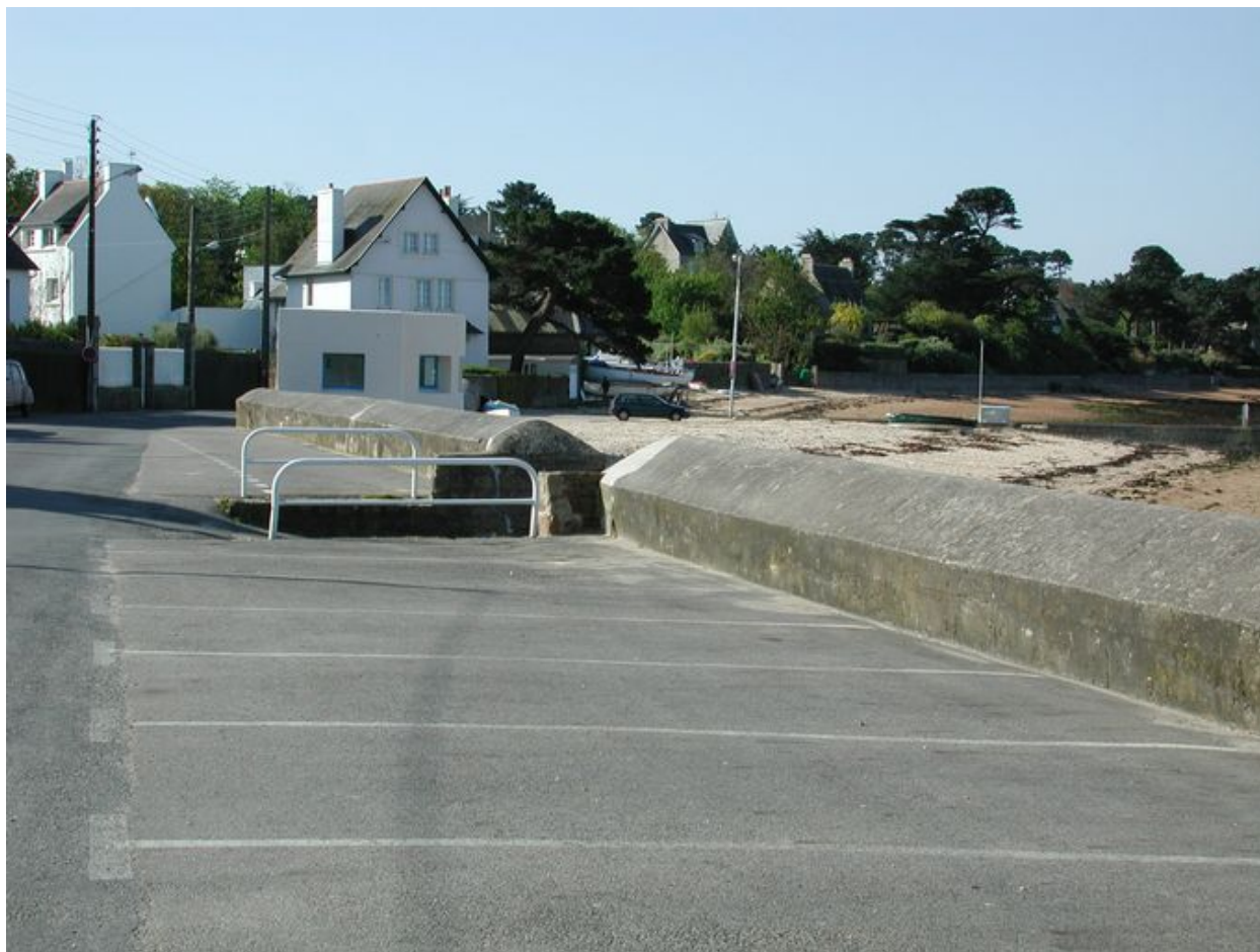
Vue générale (état en 2002). En arrière-plan, le poste d'observation et de tir en béton armé
