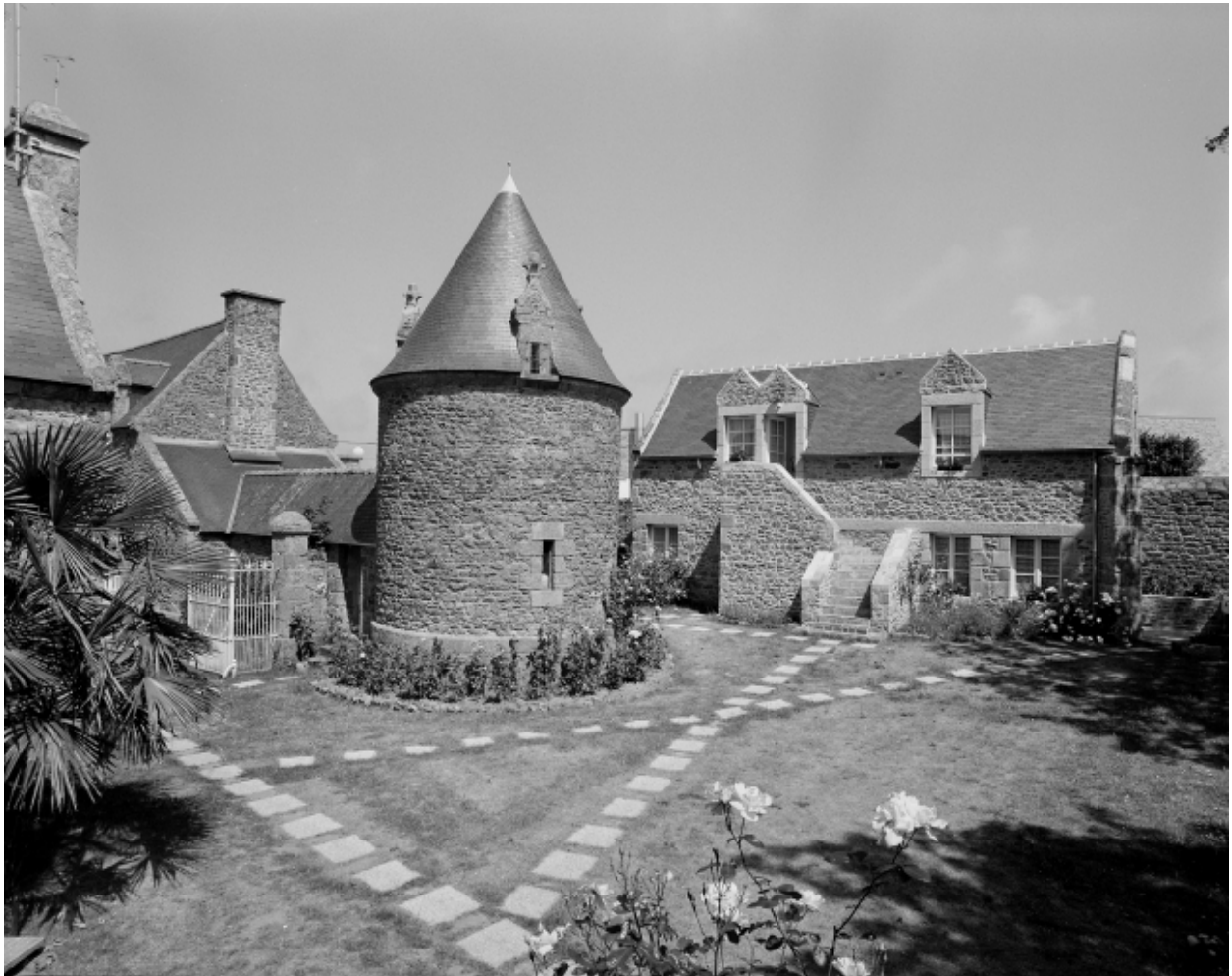
Vue générale de la cour carrée prise de l'ouest vers l'est.
