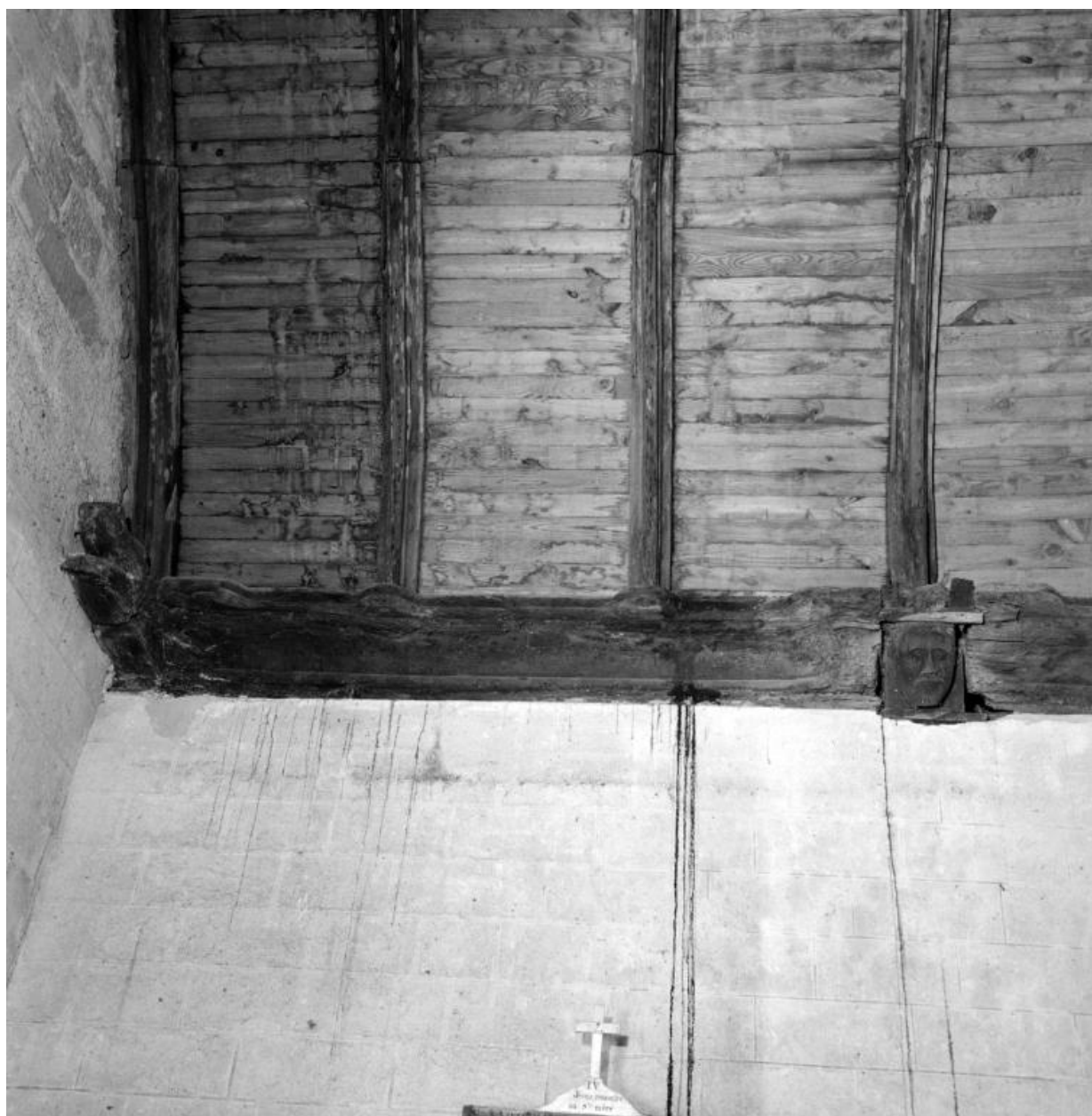
Sablères, détail du bas côté nord partie ouest.
