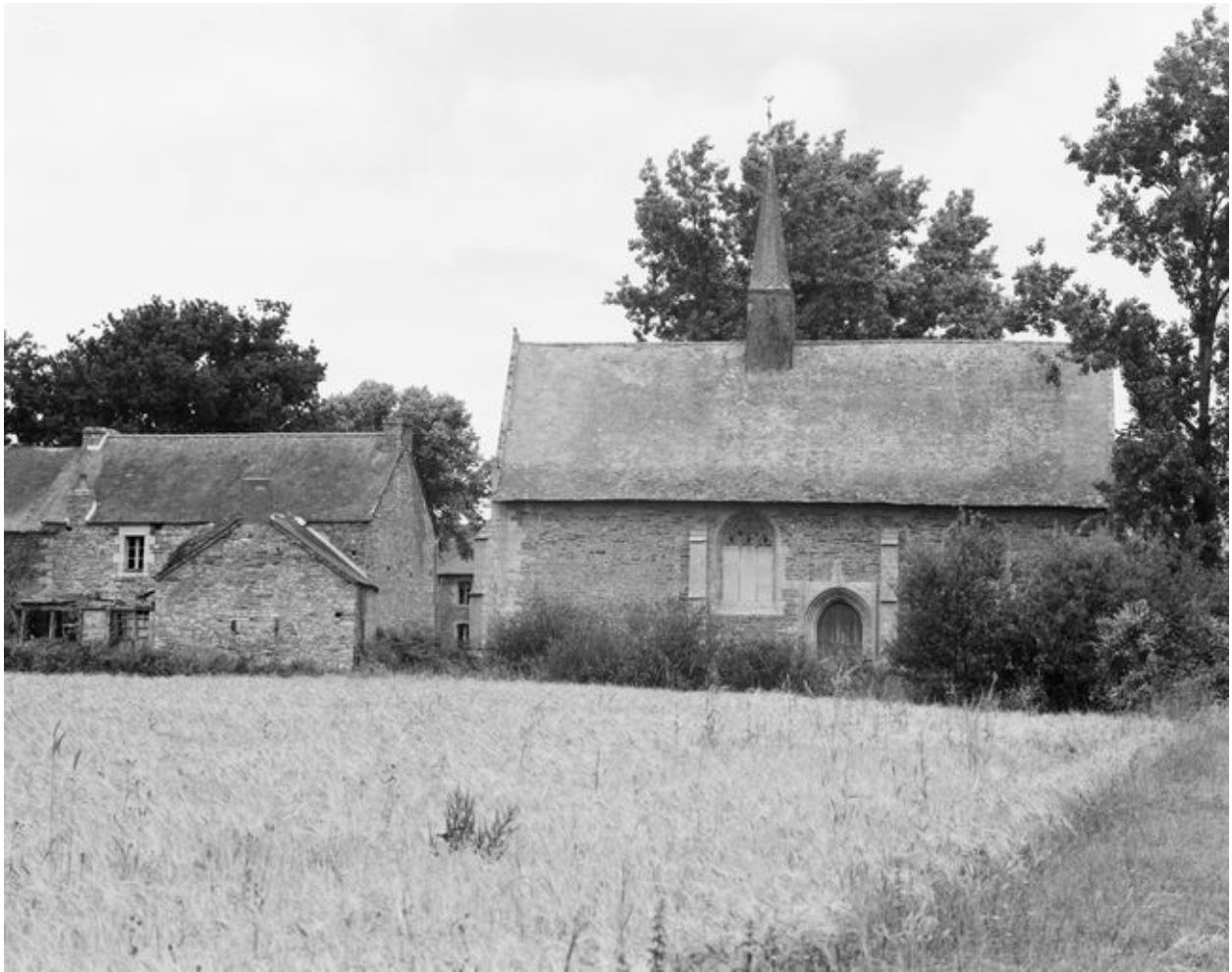
Vue de situation prise du sud
