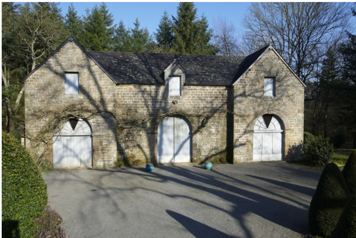
Ecurie, façade ouest.
