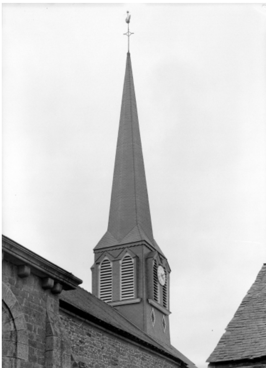
Elévation Nord, clocher : vue générale
