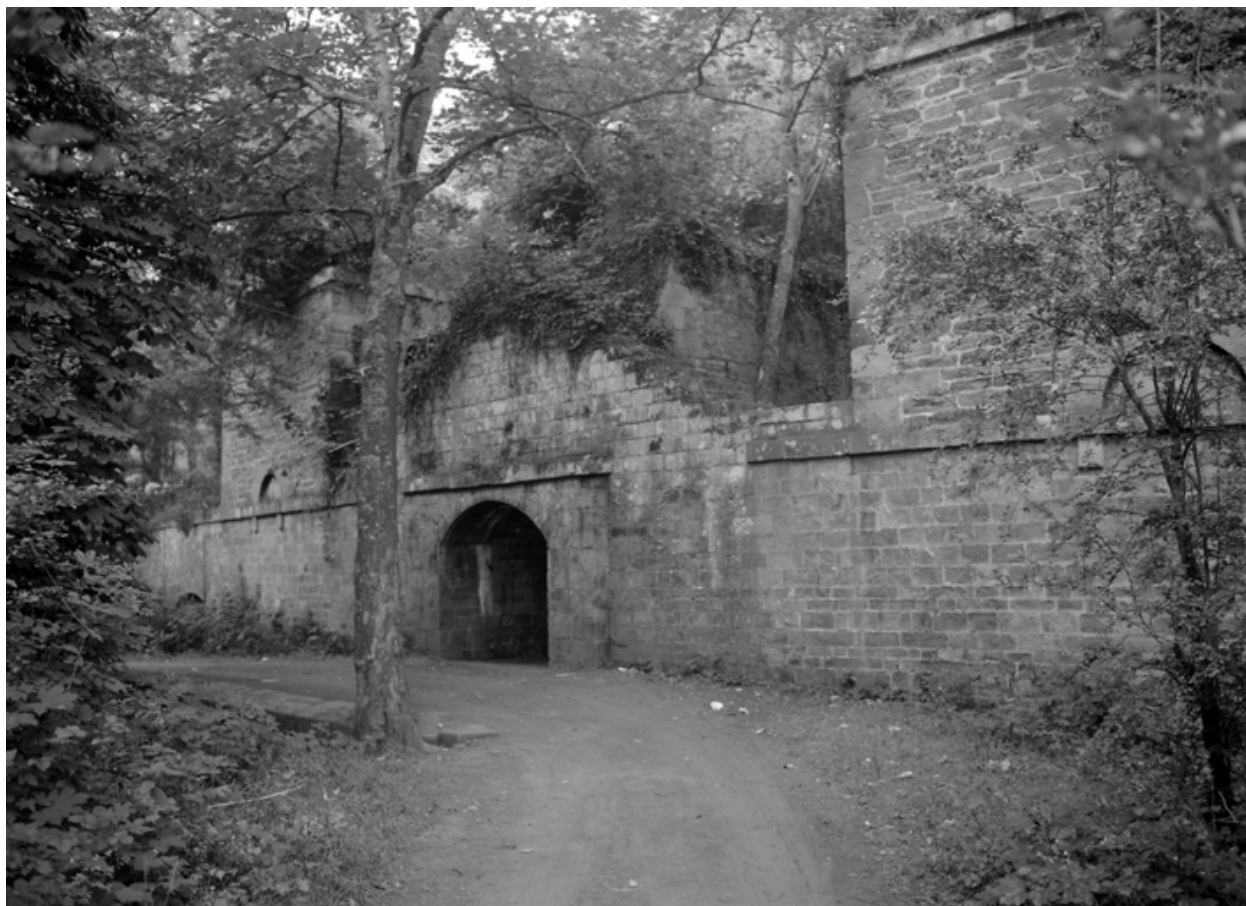
Le Palais, enceinte urbaine, réduit G, gorge, état dans les années 1970.
