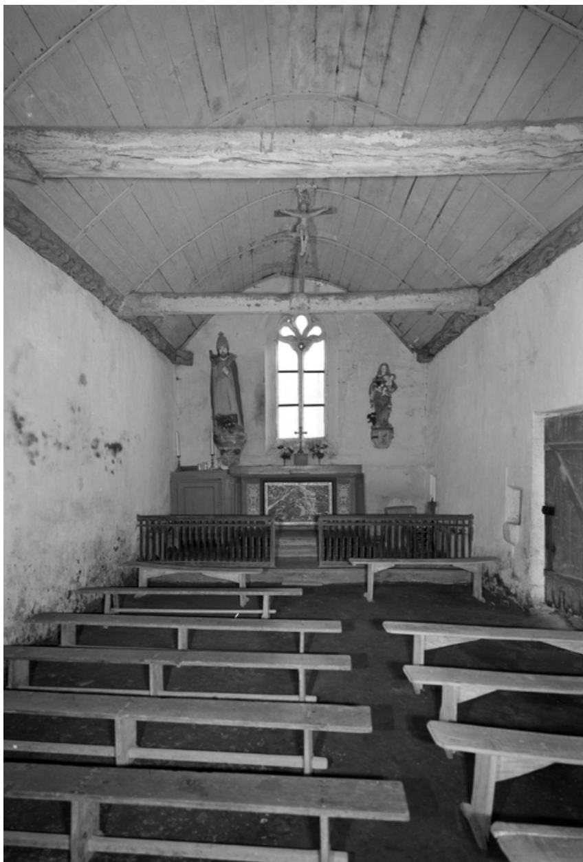
Vue intérieure vers l'est
