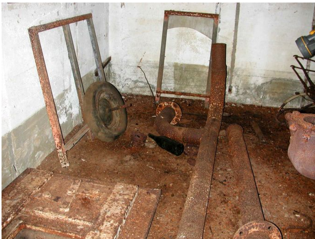
Vue de la chambre de troupe de gauche : tuyaux de ventilation (état en 2003)
