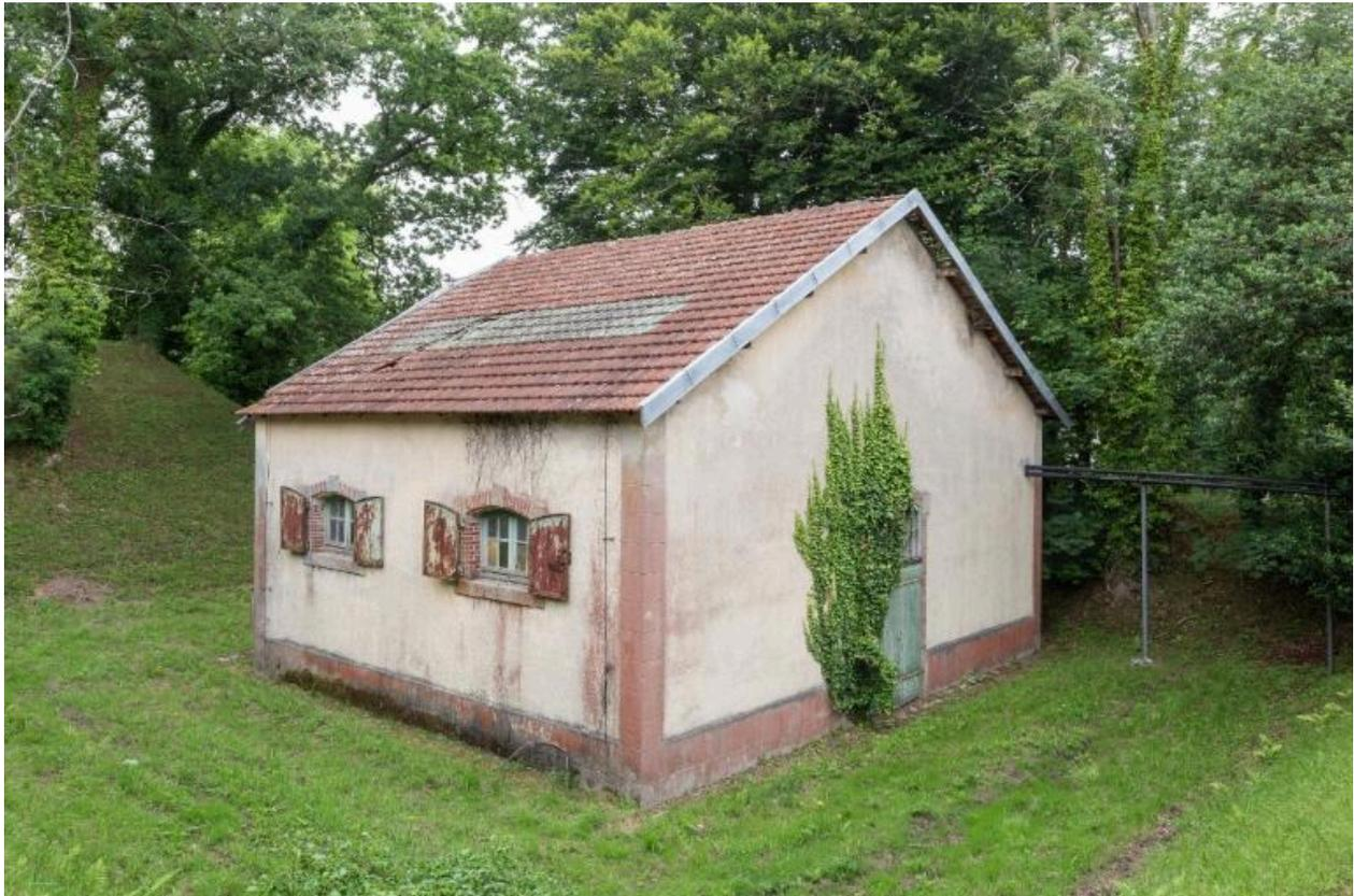
Vue du bâtiment E22 depuis le sud-ouest (état en 2025). Le bâtiment est couvert en tuile plate sur charpente métallique ; il a conservé ses huisseries d'origine et ses volets métalliques. Il est entouré par des merlons de terre
