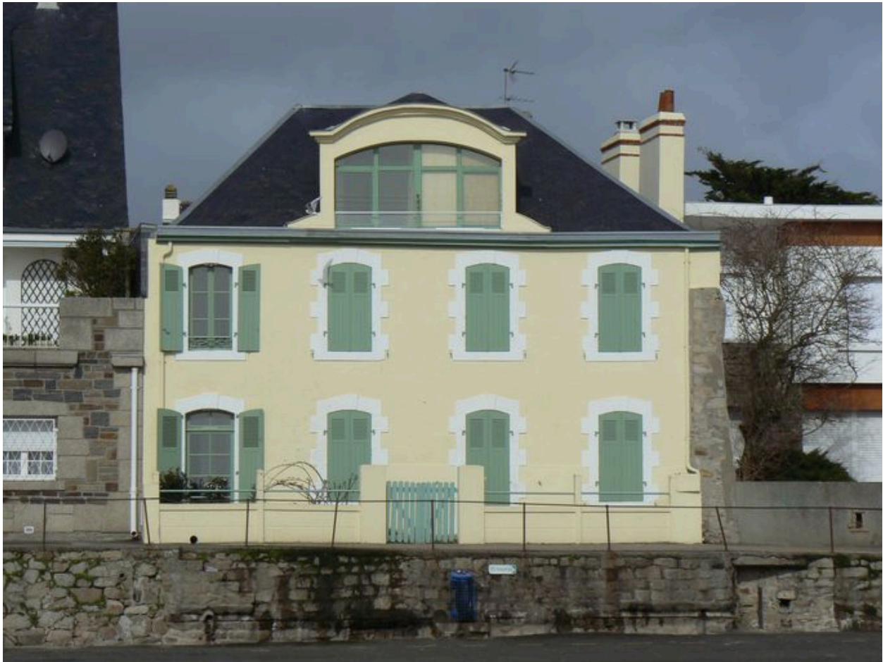
Vue générale de la maison de villégiature du 13 rue des Goëlands
