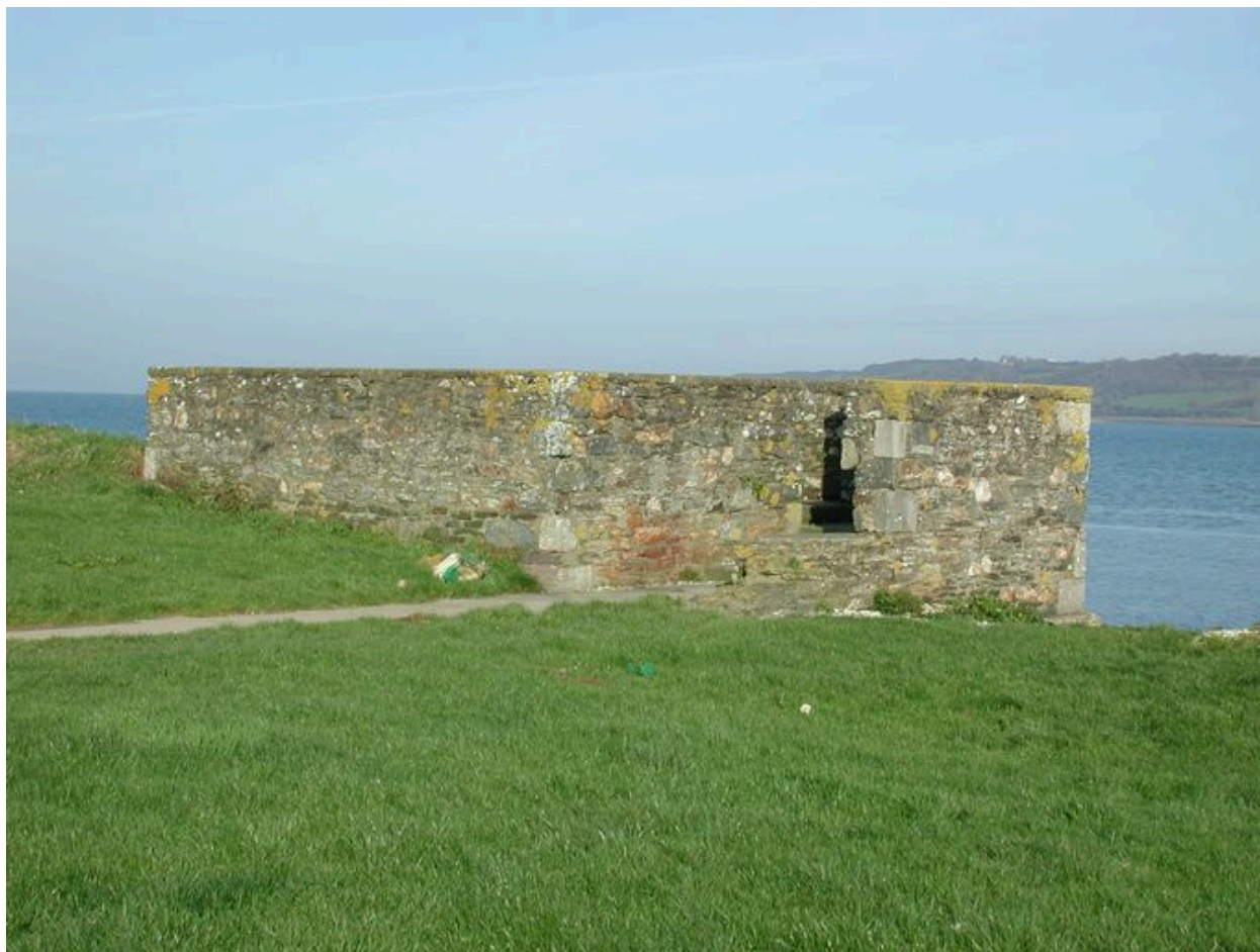
Vue de l'une des cuves pour canon antiaérien de 4 cm (état en 2002)
